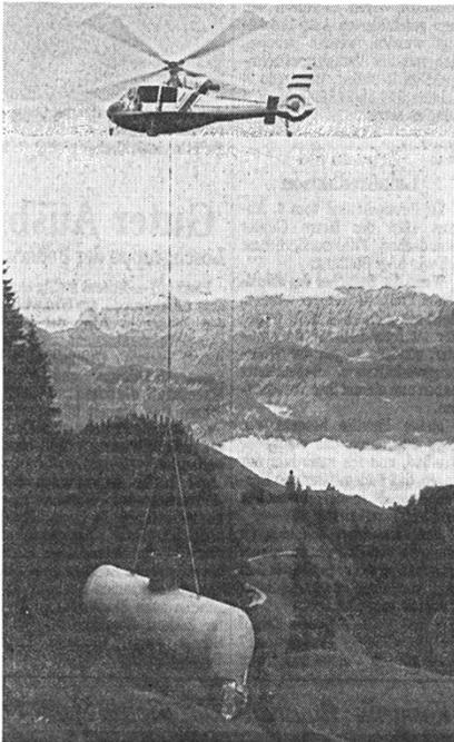
Auf dem Brünstein ratterten Baumaschinen: Die Wasserversorgung des DAV-Brünsteinhauses wurde erweitert und eine neue Kläranlage installiert. Der neue Wasserbehälter im Gewicht von 1,2 Tonnen wurde mit einem Hubschrauber auf den Berg gebracht. Foto: Seebacher
